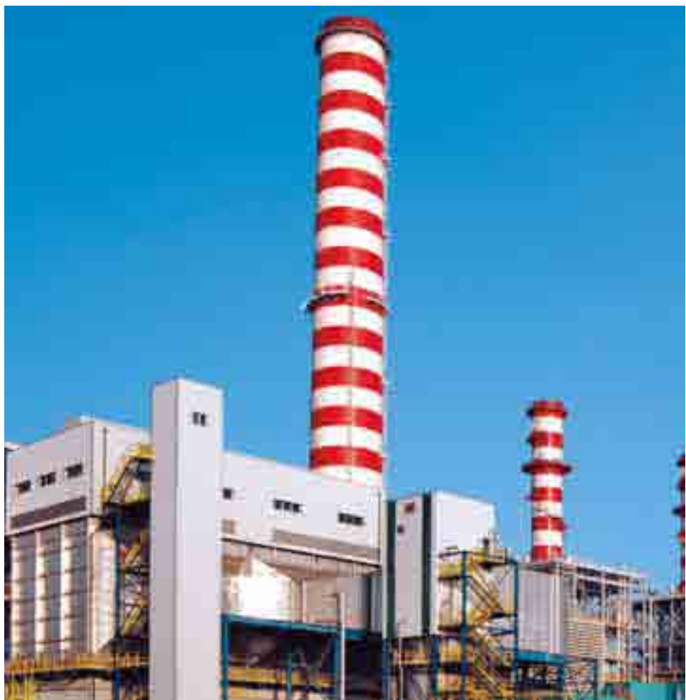
La centrale di Civitavecchia , che già alla fine dell'anno sarà riconvertita a carbone
