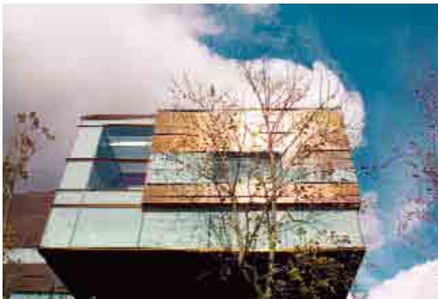
Edificio progettato da N! Studio
